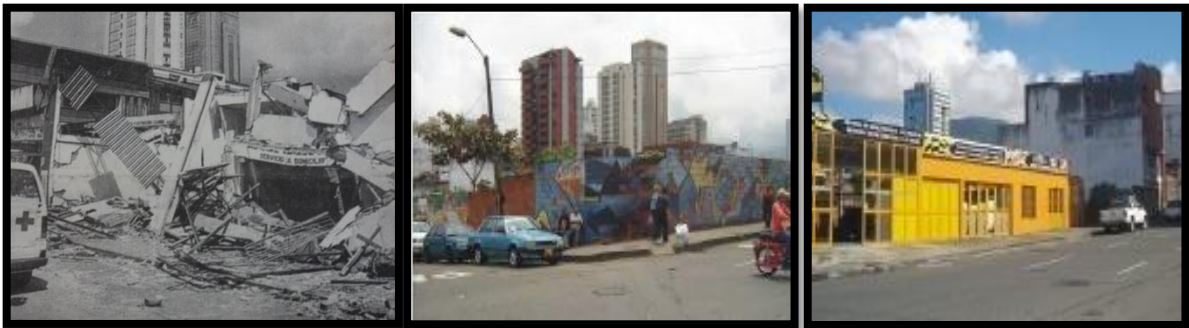
Fotos 12, 13 y 14: Lotes y nuevas construcciones después del sismo de 1999 en el Sector Plaza de Bolívar Fuente: Diario del Otún (1999) Alcaldía de Pereira (2007).
