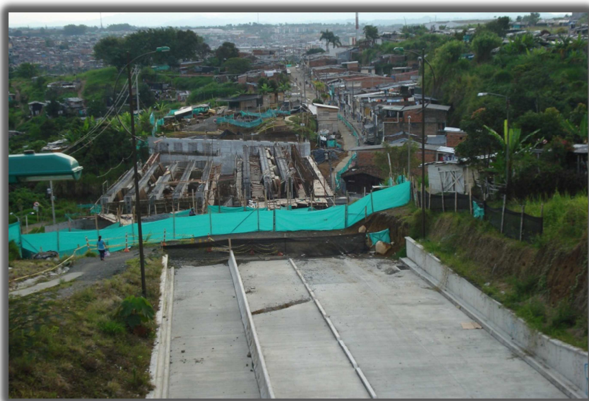
Foto 4. Proyecto de infraestructura sobre el barrio El Plumón. Por Felipe Chica, 2012.
